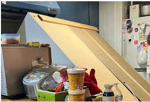
2022.3.16 木ネジも外れて戸棚が倒壊(執筆者宅)
