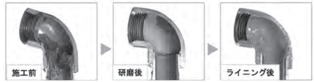
図-3 ライニング工程
