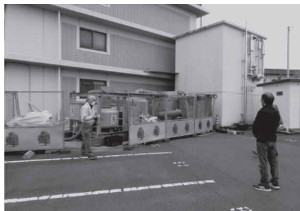
写真-11 機材設置状況
