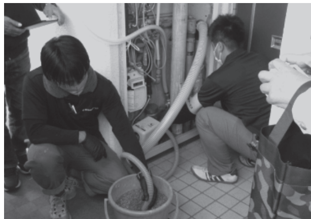
写真-9 研磨作業状況
