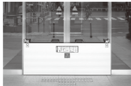
図11 建物用止水板設置例
