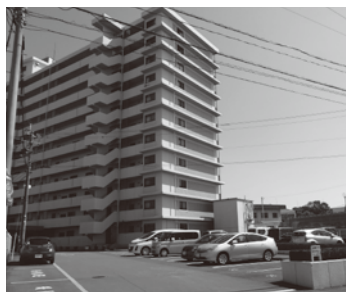
写真-1 避難ビルの指定を受けた小戸町の 11階建てAマンション
