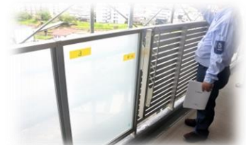
バルコニー手摺取替
